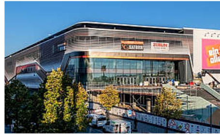
Nur noch wenige Tage vergehen bis zur Eröffnung der Berliner EAST SIDE MALL. Foto: Christian Kruppa
